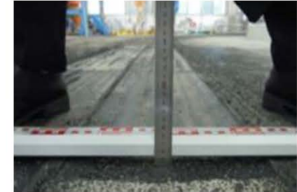
개질 SMA 포장 육안조사
