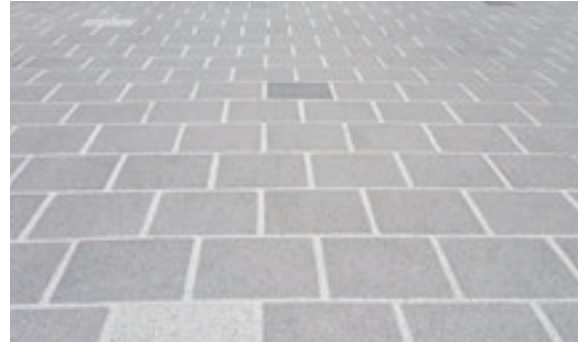
대일텍 3D-HOLE블록 시공사진
