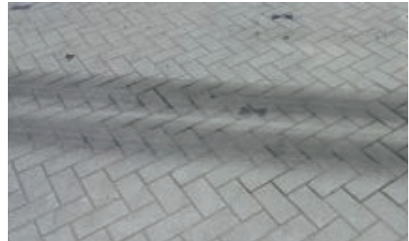
대일텍 3D-HOLE블록 시공사진
