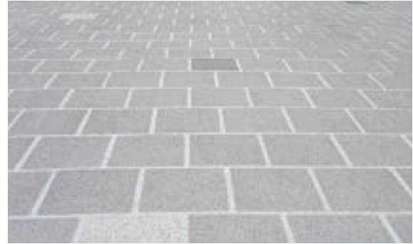
대일텍 3D-HOLE블록 시공사진
