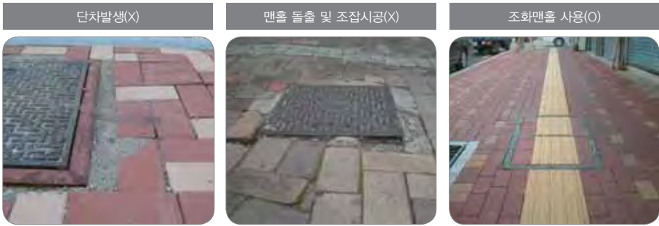
〈그림 3.74〉 맨홀 각형 접속부 시공사례
