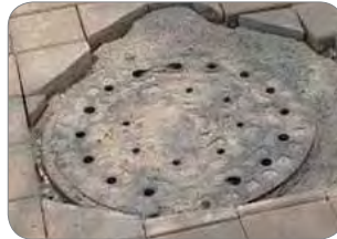
〈그림 3.73〉 맨홀 원형 접속부 시공사례
