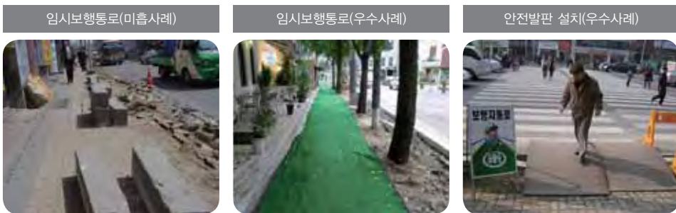
<그림 3.7> 임시보행로 설치 사례
