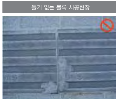
〈그림 2.9〉 돌기 없이 설치된 블록의 파손 형상
