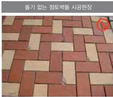
〈그림 2.9〉 돌기 없이 설치된 블록의 파손 형상
