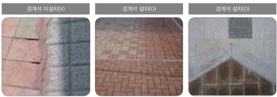
〈그림 3.83〉 상이포장간의 접속부 시공사례
