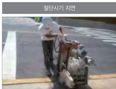
〈그림 3.41〉 L형측구 수축줄눈 설치 사례
