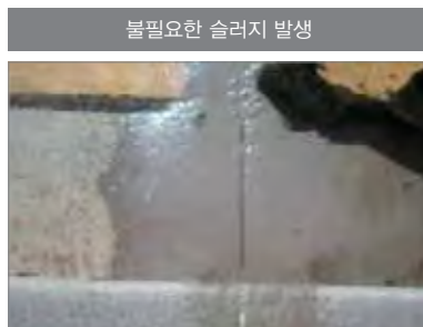
〈그림 3.41〉 L형측구 수축줄눈 설치 사례
