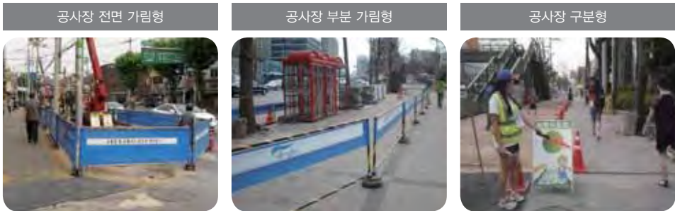
<그림 3.5> 보행통로 및 안전휀스 설치유형
